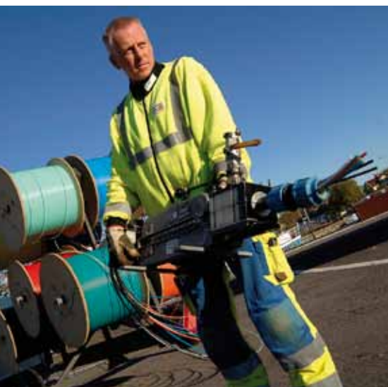
Thomas förbereder blåsning av fiberrör
