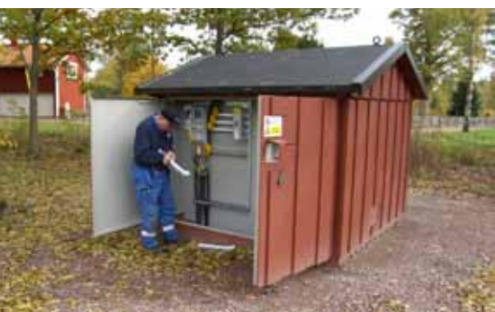
Anders kopplar in markförlagd kabel på landsbygden
